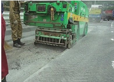
①舗装の切削
