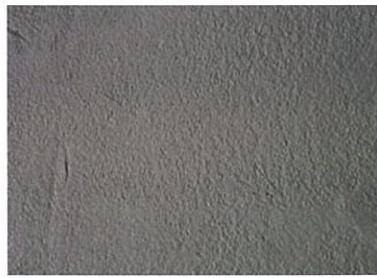
⑧シートによる封緘養生
