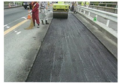
⑨橋面防水及び舗装復旧
